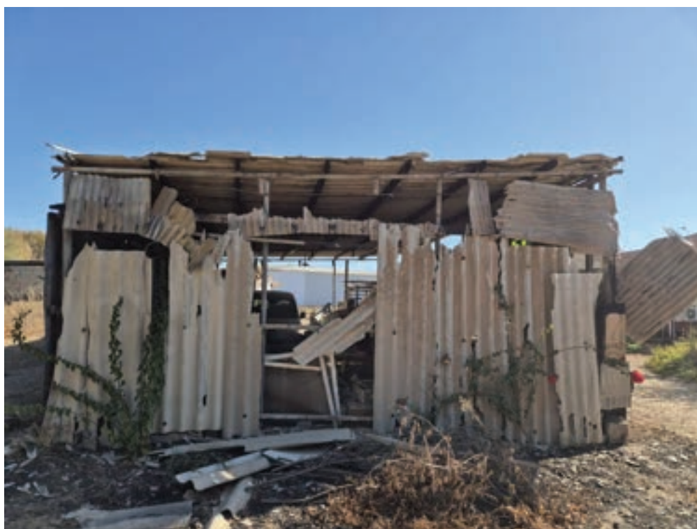
תמונה 28: מפגע אסבסט מושב נגה במועצה אזורית לכיש
