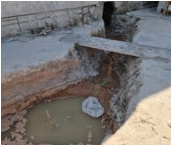
תמונה 36: תשתית לקייה להובלת תשטיפים תעשייתיים במפעל לחיתוך ועיבוד שיש
